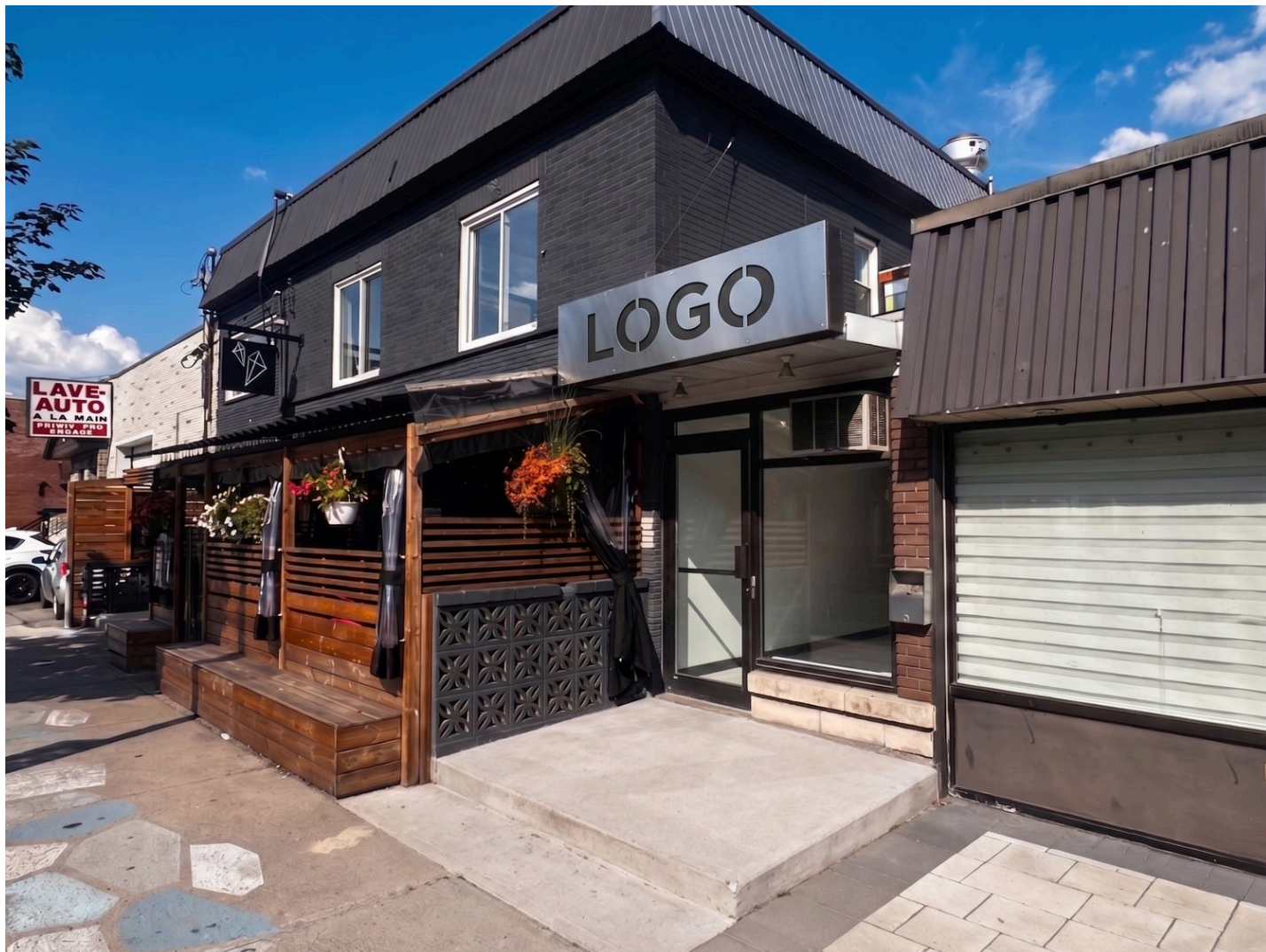
Façade sur la rue Hochelaga – vitrine et enseigne / Hochelaga Street frontage – storefront and signage
