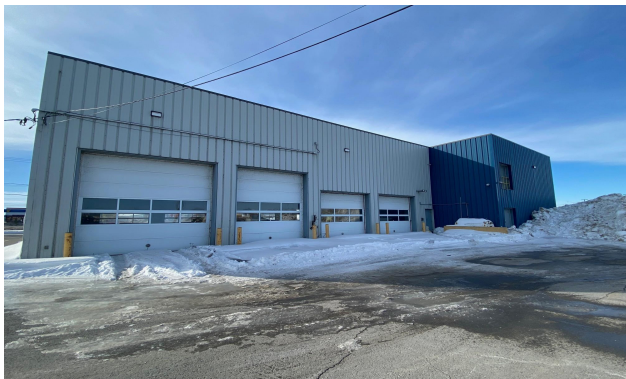
Arrière du bâtiment Behind the building
